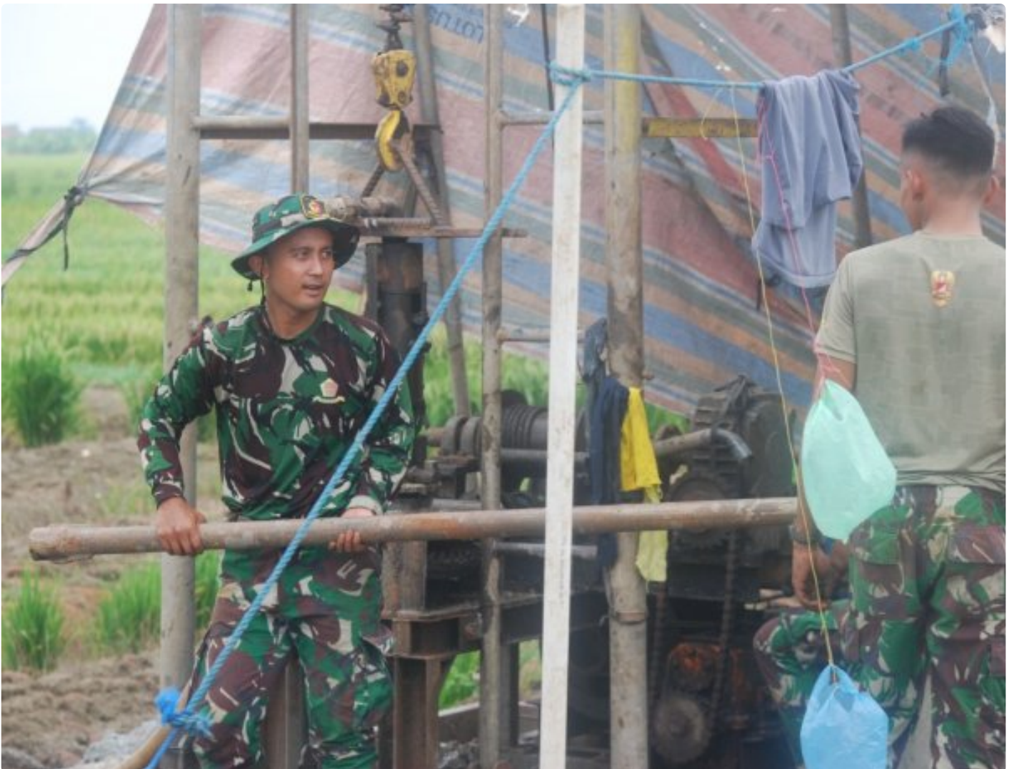
Proses pembuatan sumur bor oleh anggota satgas TMMD Kodim Demak
