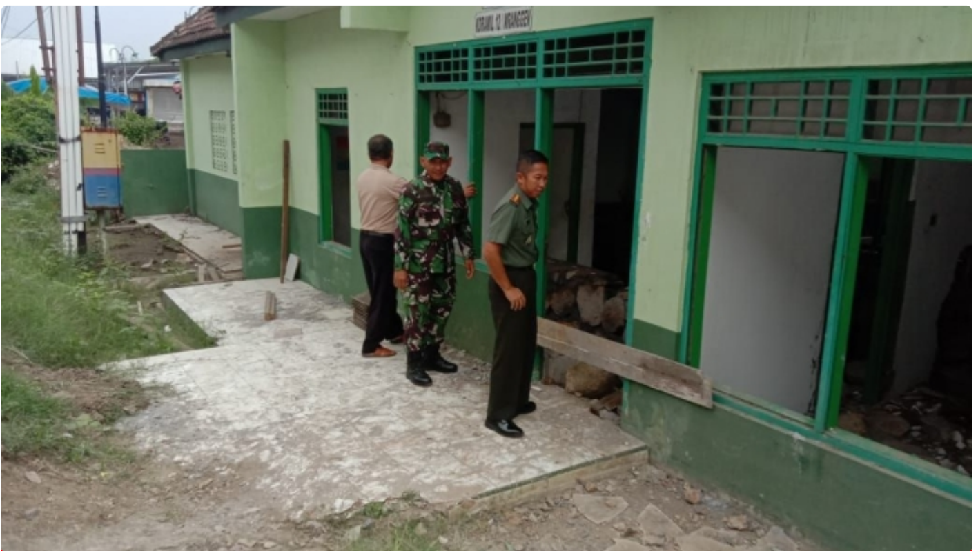
Kegiatan Dandim Demak Tinjau Pelaksanaan Renovasi Koramil 12/Mranggen
